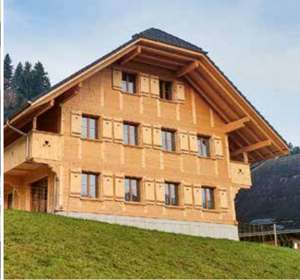
Ersatzneubau Wohnhaus. Die Gerber Holz AG konnte für dieses Wohnhaus das verleimte Bauholz, das Wandholz und viele weitere Massivholzbauteile liefern.
